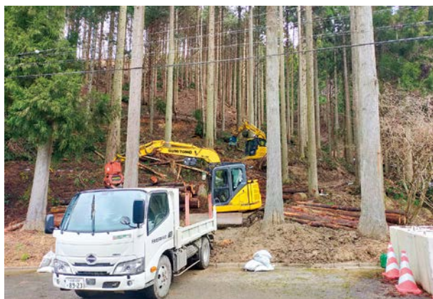
3 t ダンプに積み替えて運搬
